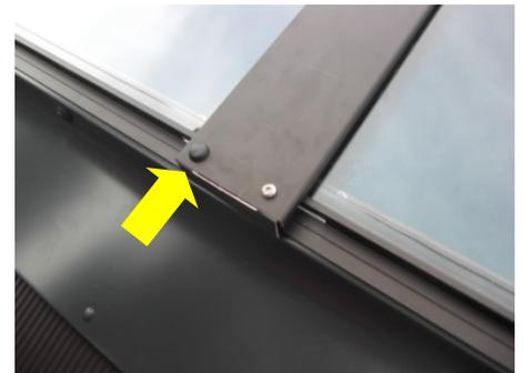
Jeden Abdeckleisten-Winkel mit 3 Stk. Spenglerschrauben befestigen.
